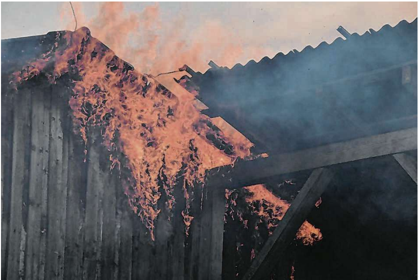
Wenn der Feuerteufel zuschlägt, ist es gut, wenn eine ausreichende Versicherung vorhanden ist. Archivbild: Fritz Arnold
